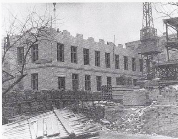
Строительство лабораторного корпуса «Л» МИХМа. Фото конца 1950-х гг.
